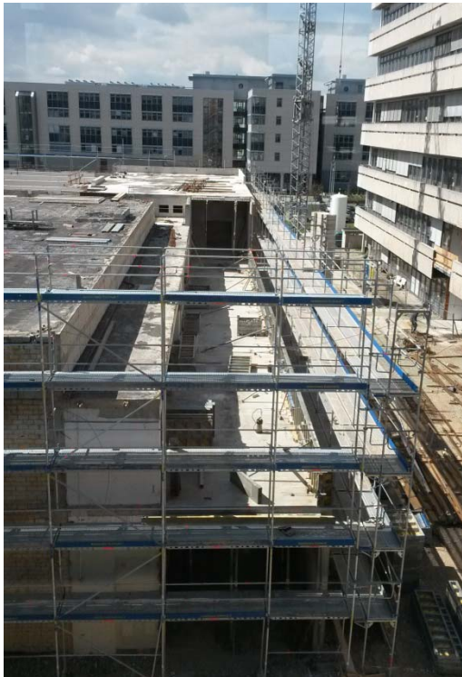
Bild 1 – Ostteil Bereich ehemaliges Gasflaschenlager
